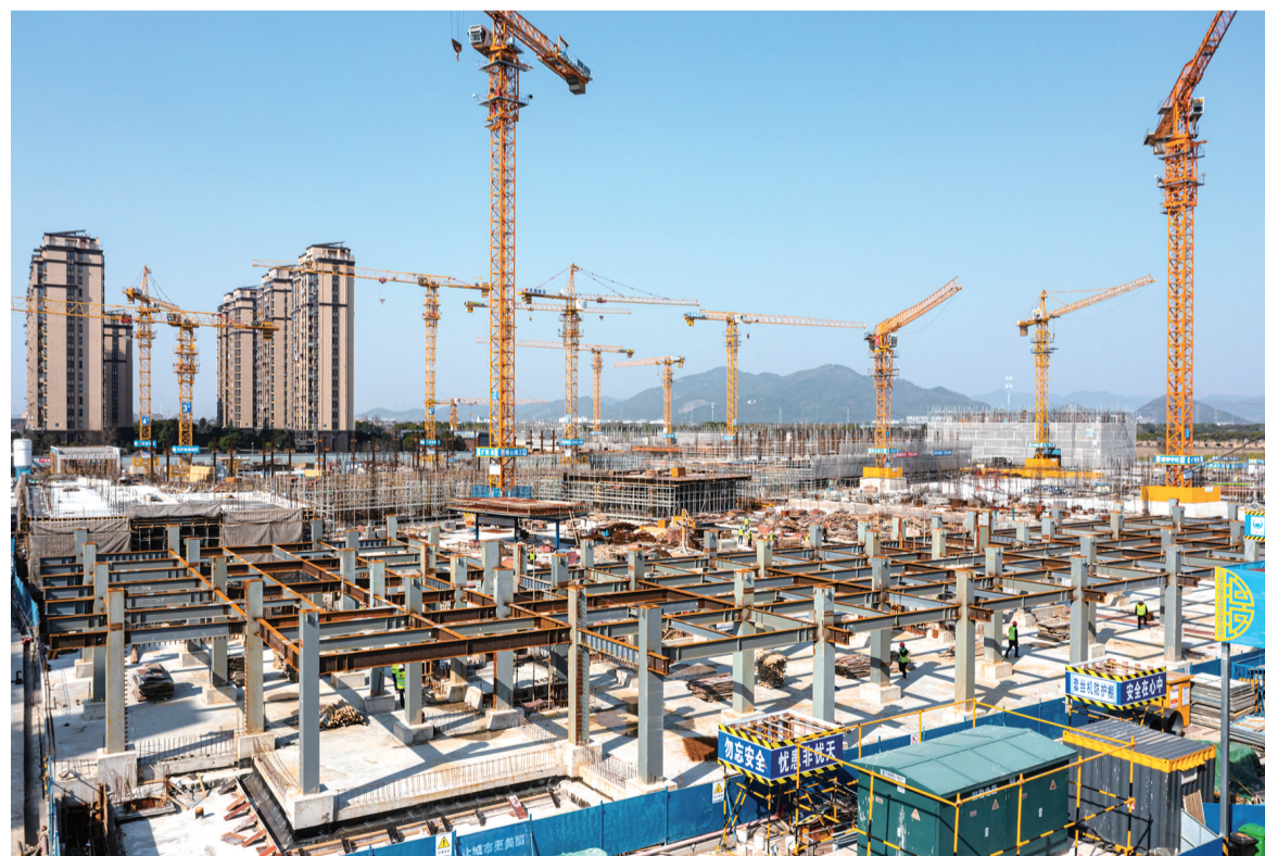
应嘉丽园北侧租赁住房项目施工现场。王涛 陈冰曲 摄
