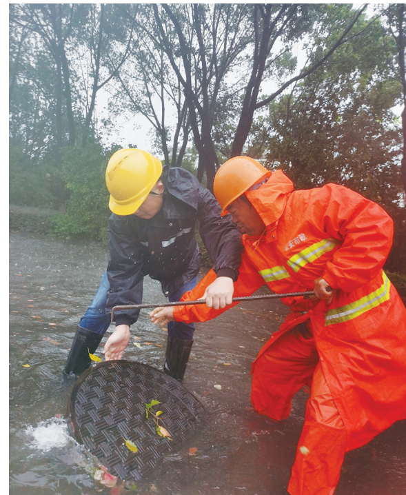
前江街道对积水路段进行清理。陈冰曲 马佳威 摄
